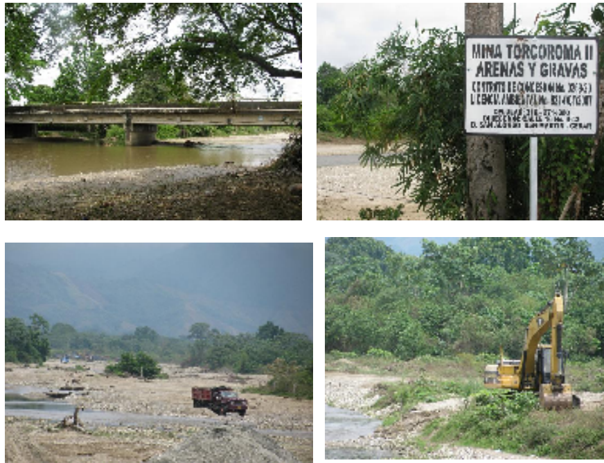
Figura 32. Quebrada la Torcoroma y su proceso de impacto por extracción de material de arrastre
