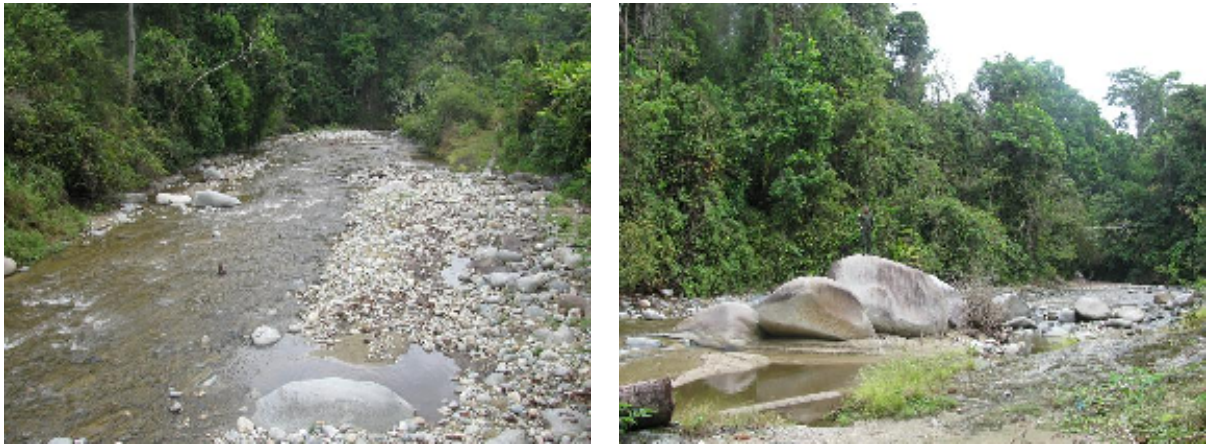
Figura 33. Bocatoma Municipio de San Martín
